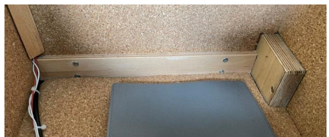
Abbildung 63: Abdeckungsleiste als Zugentlastung
