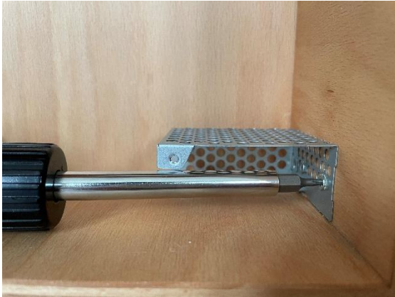
Abbildung 36: Einbau Netzteilbaustein oberer Teil
